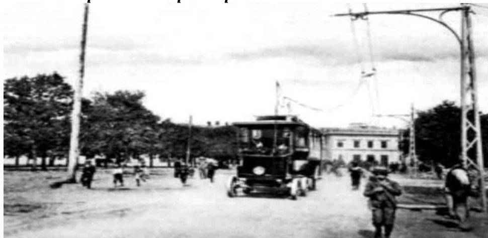
Figura 2.6 - Exemplu de omnibuz electric, pe roți, folosit în anul 1904, pentru transportul public de călători din Sibiu
