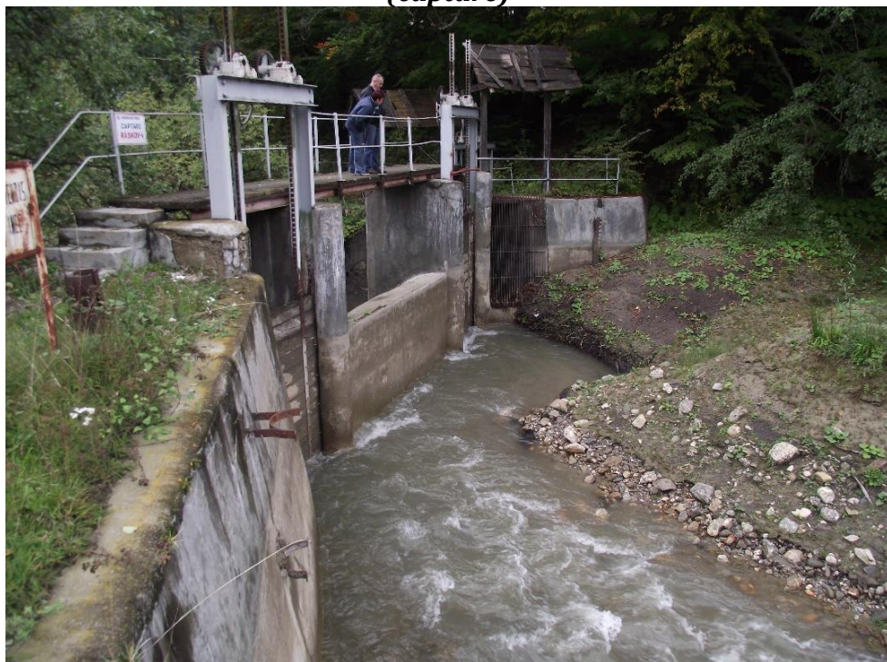
Fig. 20. Centrala hidroelectrică Râșnov II (1936) - priza de apă (captare)
