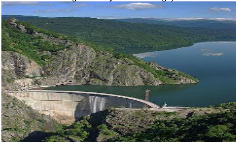
Fig. 40. Barajul Vidraru - Argeș
