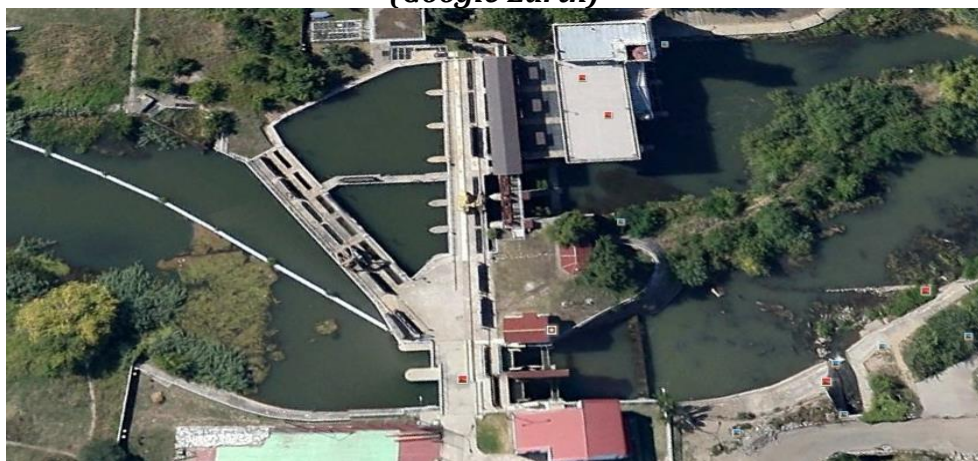
Fig. 12. Nodul hidrotehnic și centrala hidroelectrică Timișoara (Google Earth)
