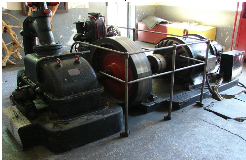
Fig. 22. Hidroagregat cu turbină Pelton, centrala hidroelectrică Suseni, 1938
