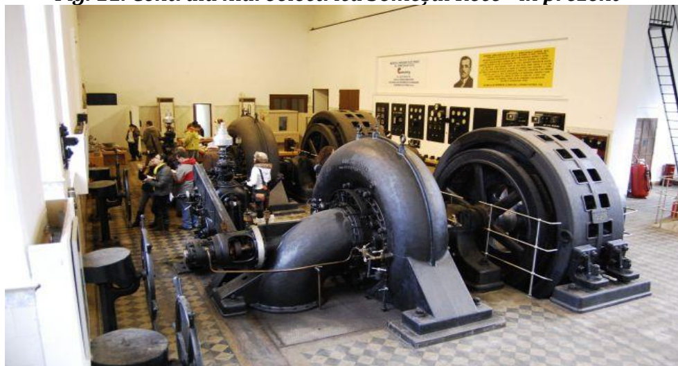
Fig. 11. Centrala hidroelectrică Someșul Rece - în prezent
