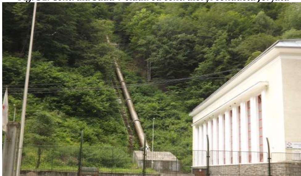
Fig. 31. Centrala Sadu V clădirea centralei și conducta forțată
