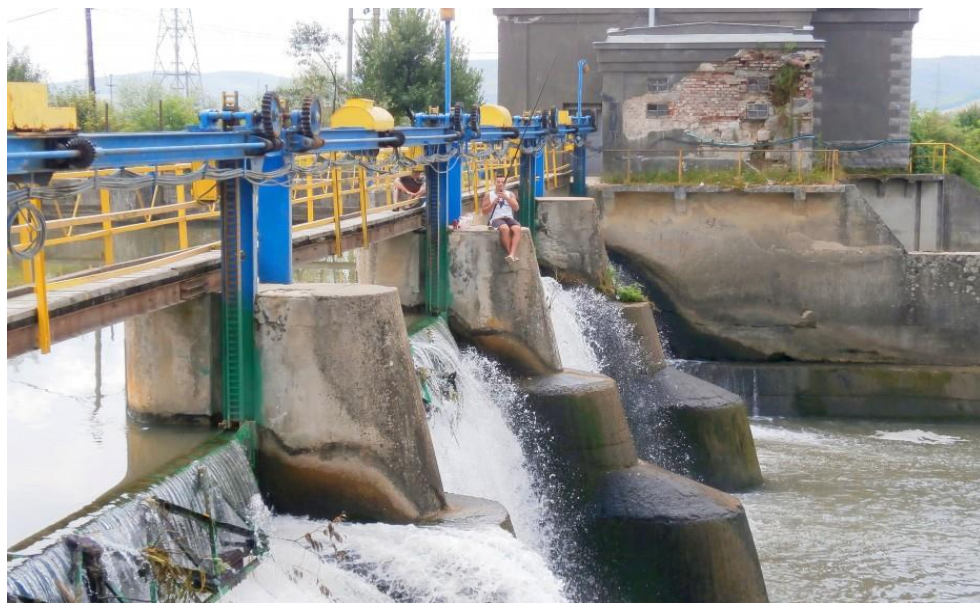
Fig. 14. Barajul și centrala Mănăstirea Dej - astăzi [69]
