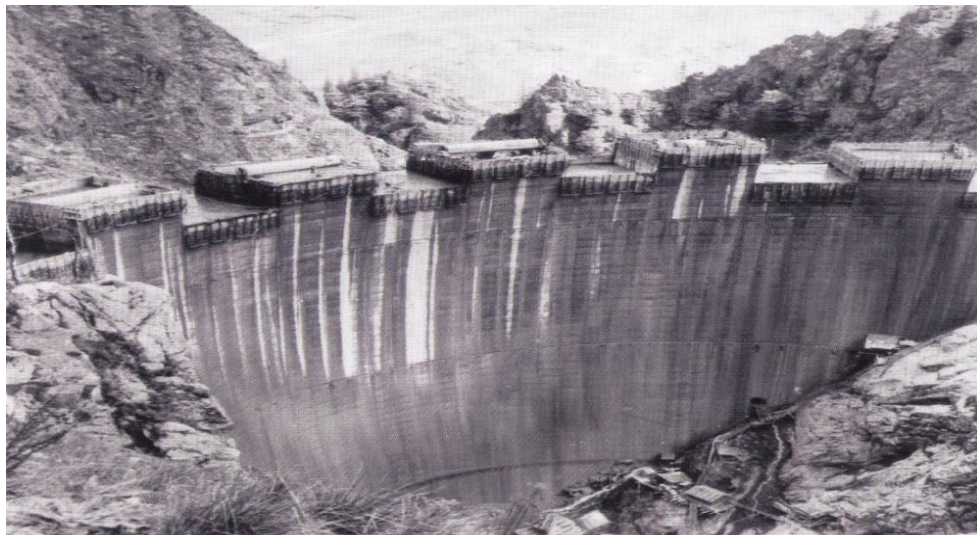
Fig. 39. Barajul Vidraru - în construcție, anul 1965
