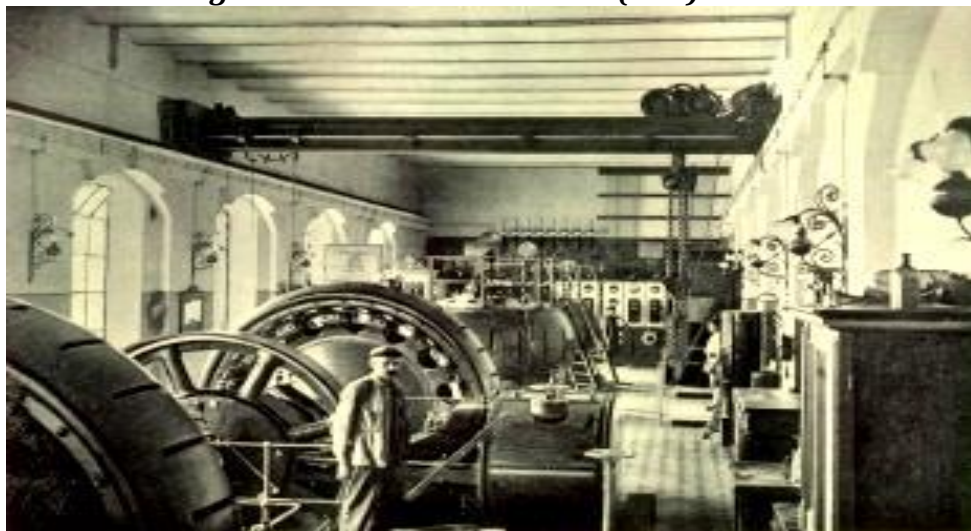
Fig. 5. Centrala hidroelectrică (CHE) Sadu 1
