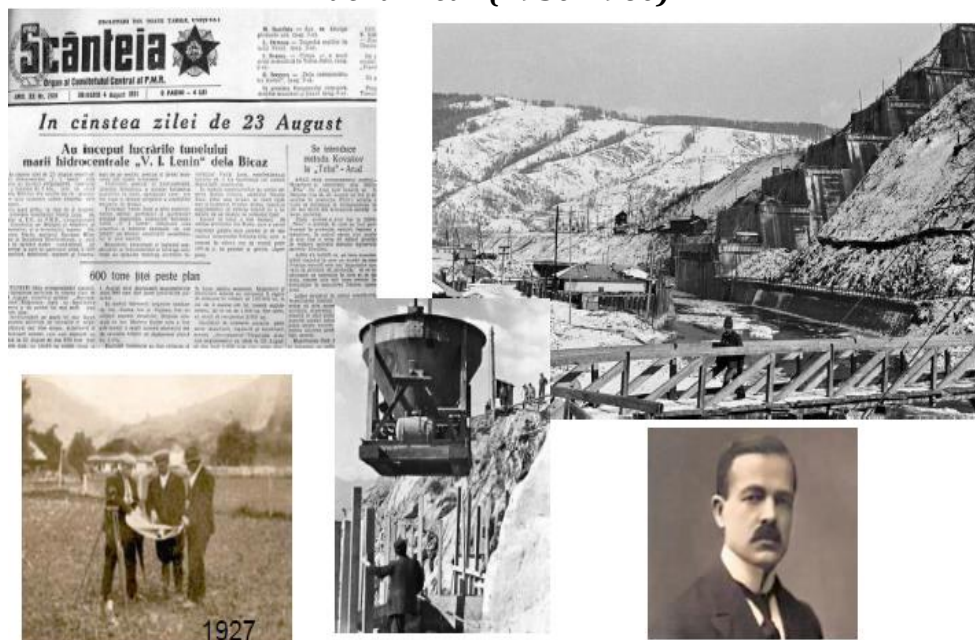
Fig. 37. Etape de realizare la barajul "Izvorul Muntelui" & centrala de la Bicaz (1950-1960)
