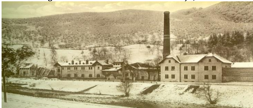
Fig. 4. Centrala hidroelectrică Grozăvești, 1989
